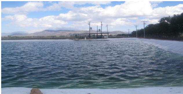
Figura 4. Reservorio de agua
