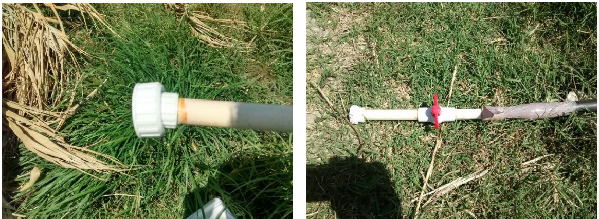
Figura 22. Tuerca unión utilizada para desmontar los conectores.
