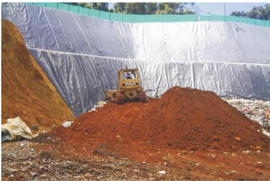
**Figura 2.10. El uso de maquinaria es necesario para la colocación de la Geomembrana.**
