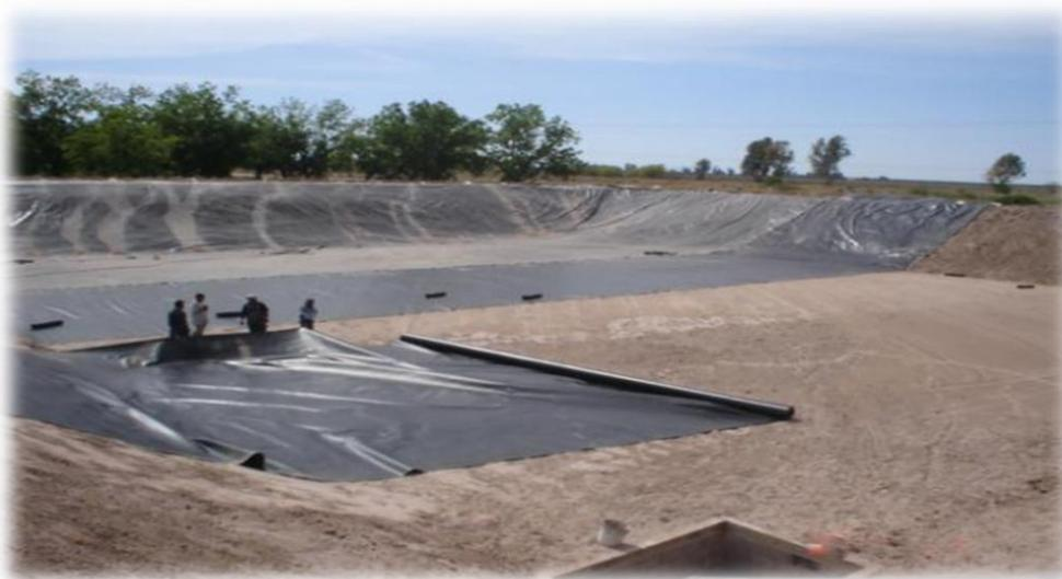
**Figura 2.12. Para la colocación correcta de la geomembrana es disponer de mano de obra.**
