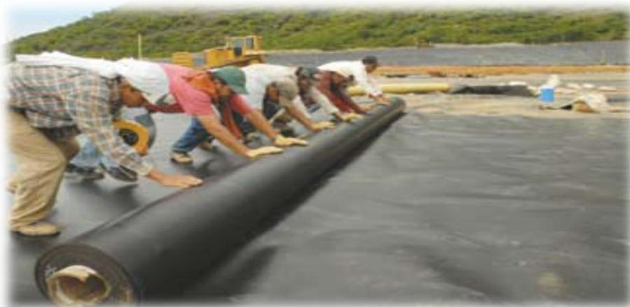
**Figura 2.13. Para la colocación correcta de la geomembrana es necesario desenrollar de manera uniforme para que esto quede ajustado.**
