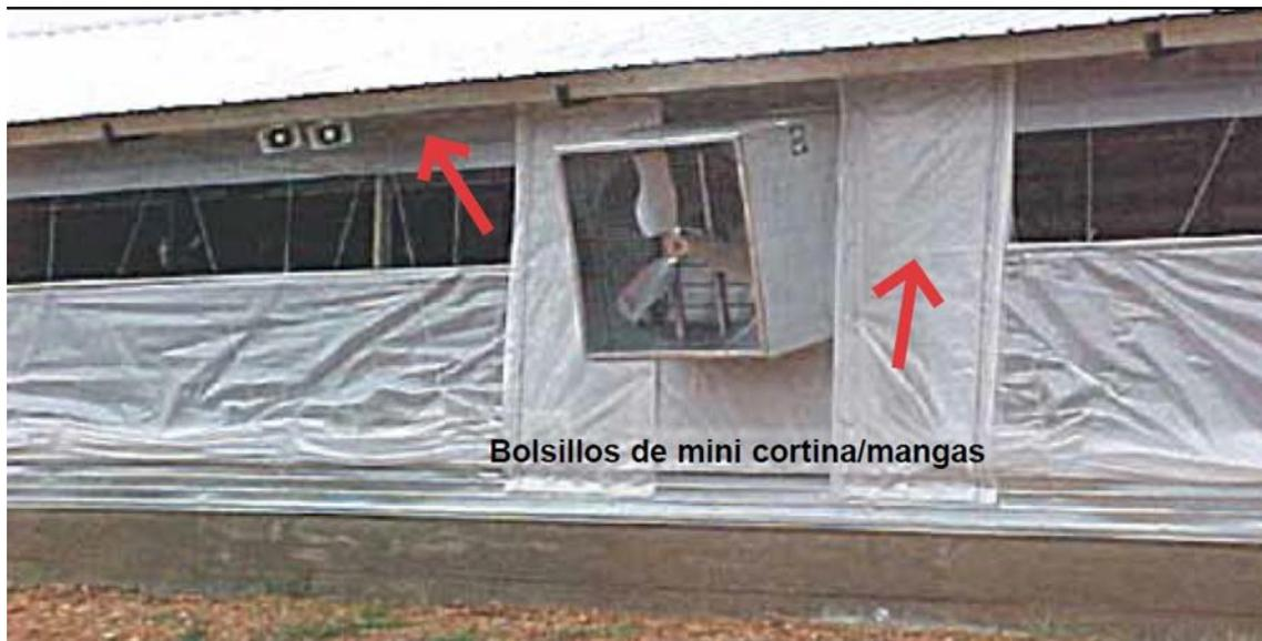
Imagen 6. Instalación de cortinas.(Cobb 2012)
