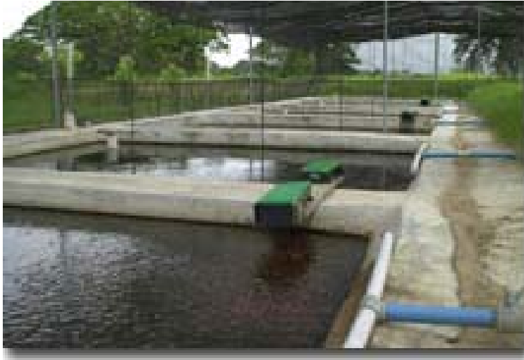
FIG 9: ESTANQUES DE CONCRETO
