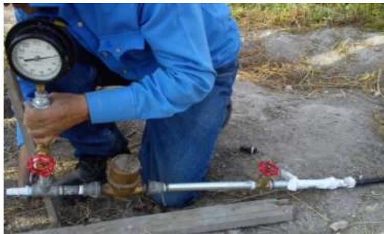
Figura 3.3. Haciendo las conexiones de los instrumentos utilizados.
