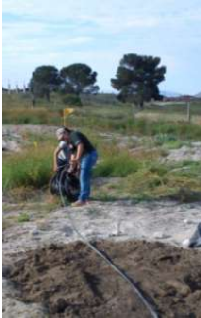
Figura 3.2. Extendiendo el rollo de manguera regante de prueba.
