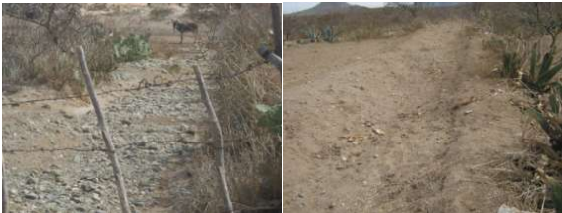
Figura 3. Acequias construidas de tierra y bordos.
