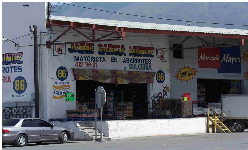
Figura 9. CEDA Saltillo: Características de una bodega
