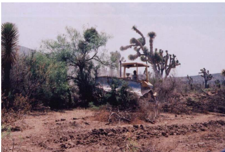
Figura 3.-Maquina desmontadora en funcionamiento.
