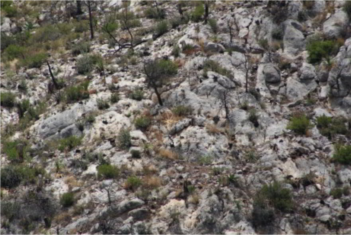
Fotografía 8.- Condiciones actuales de la zona afectada.
