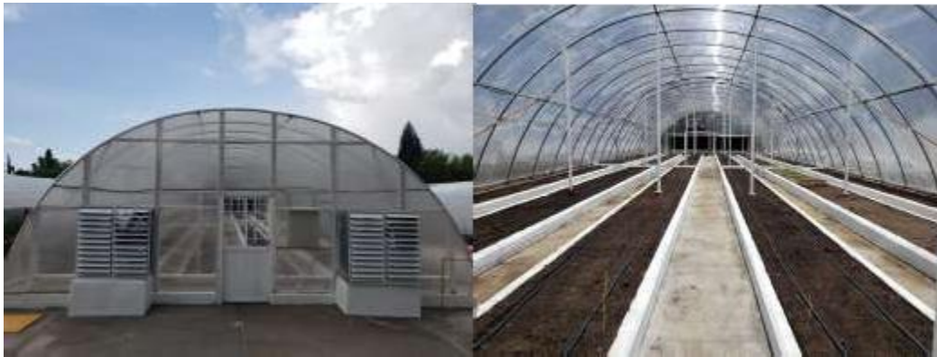
Figura 12. Infraestructura del invernadero No. 5 Campo Experimental Buenavista.
