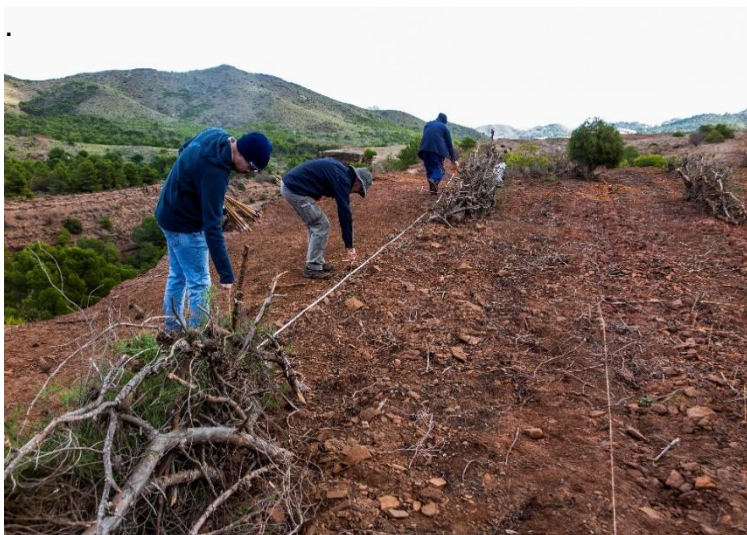
Figura 6. Fabricación las fajinas, las banquetas y los posaderos procede de podas realizadas en los alrededores de la parcela FiAmbRes, 2018.
