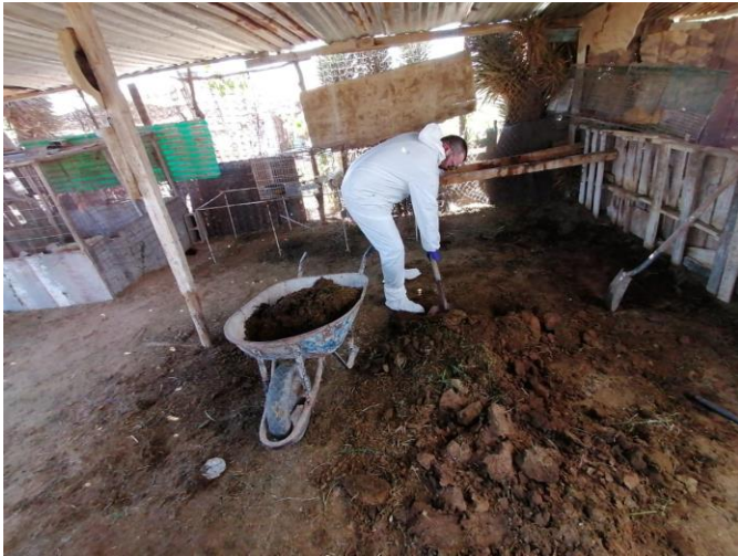
Remoción de capa superficial del suelo
