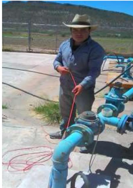
**Figura 18.** Introducción del cable de la sonda por el ADEME del pozo
