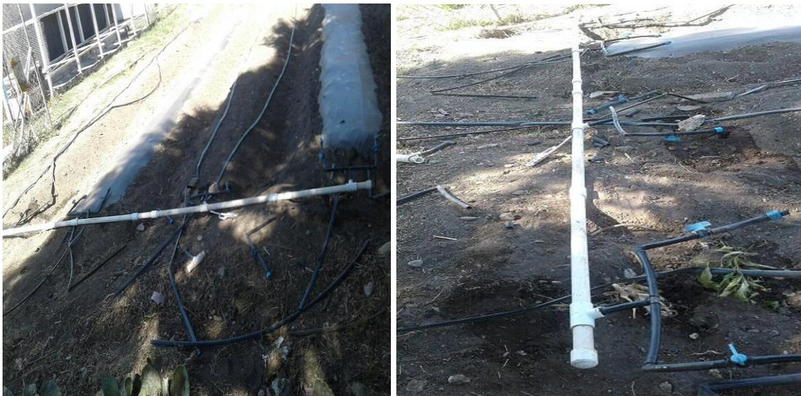
**Figura 5.-** Instalación del sistema de riego
