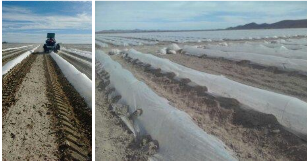
Figura 18. Instalación de agro velo. a) Instalación mecánica de agro velo, b) agro velo establecido. Fotografías obtenidas en la unidad de producción La Coquena, Paila Coahuila.
