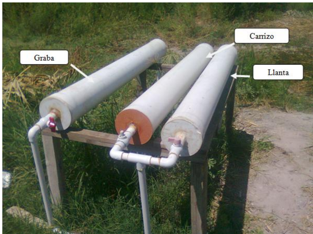
Figura 6. Sistema de tratamiento.
