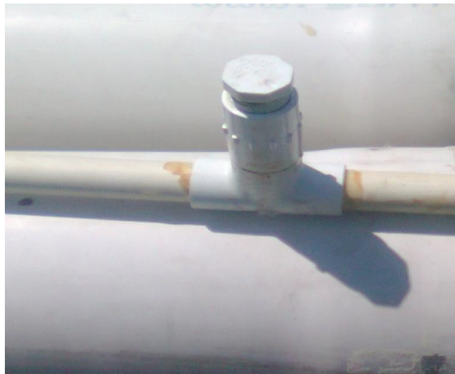
Figura 10. Válvula para realizar la inyección de la solución salina (trazador).
