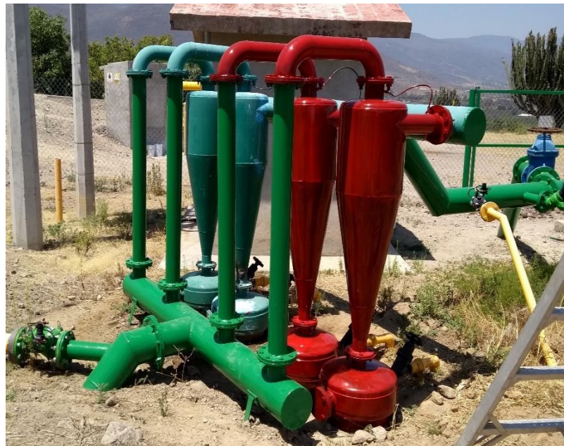
Figura 21. Conjunto de Hidrociclones (Gómez, 2017).
