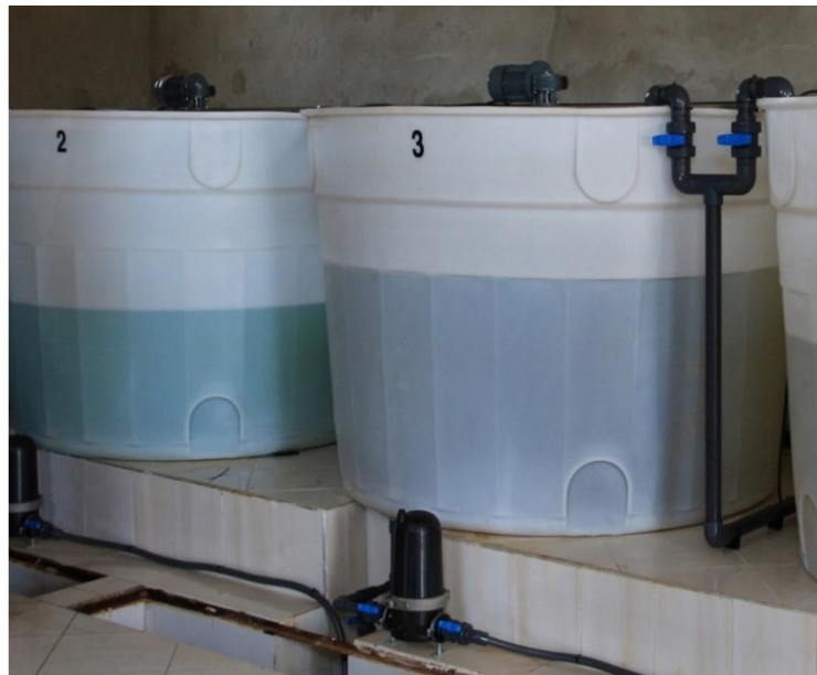
Figura 17. Inyectores por succión (Gómez, 2017).
