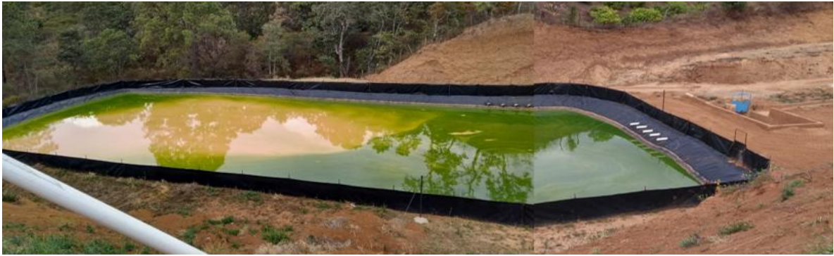
Figura 1. Reservorio con geomembrana como fuente de abastecimiento de agua para riego (Gómez, 2017).
