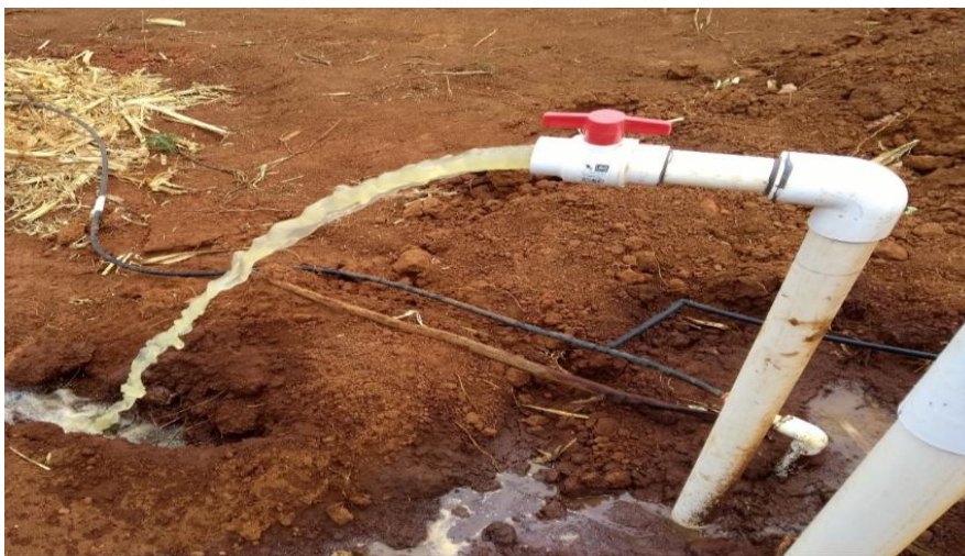
Figura 22. Dren de descarga de agua sucia (Gómez, 2017).
