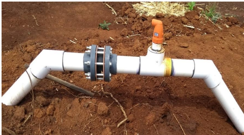
Figura 12. Válvula aliviadora de aire (Gómez, 2017).
