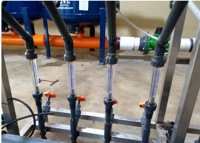
Figura 7. Rotámetro (flujómetros Venturi) (Gómez, 2017).
