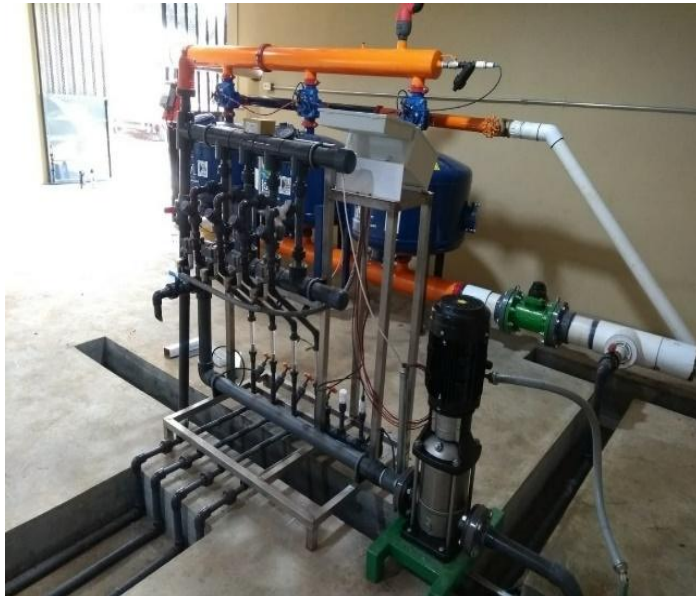
Figura 15. Bombas inyectoras (Gómez, 2017).
