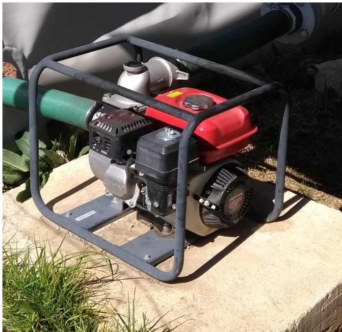
Figura 5. Motobomba de 10 Hp (Gómez, 2017).
