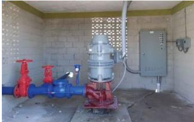
Figura 3. Bomba de turbina vertical (Gómez, 2017).
