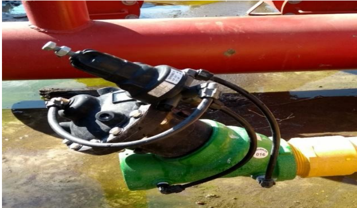
Figura 13. Válvula aliviadora de presión (Gómez, 2017).
