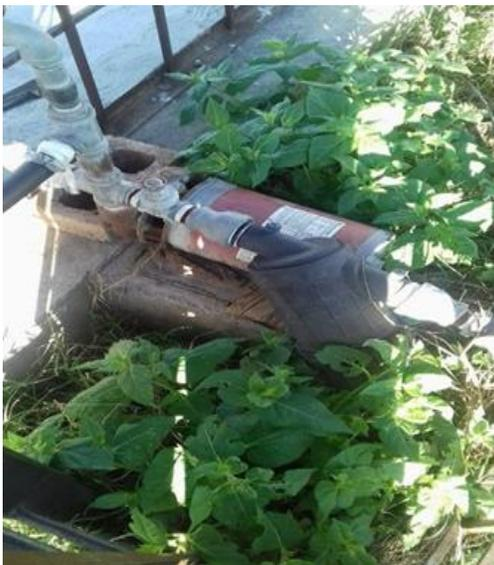
**Figura 11.** Bomba dosificadora de fertilizante.
