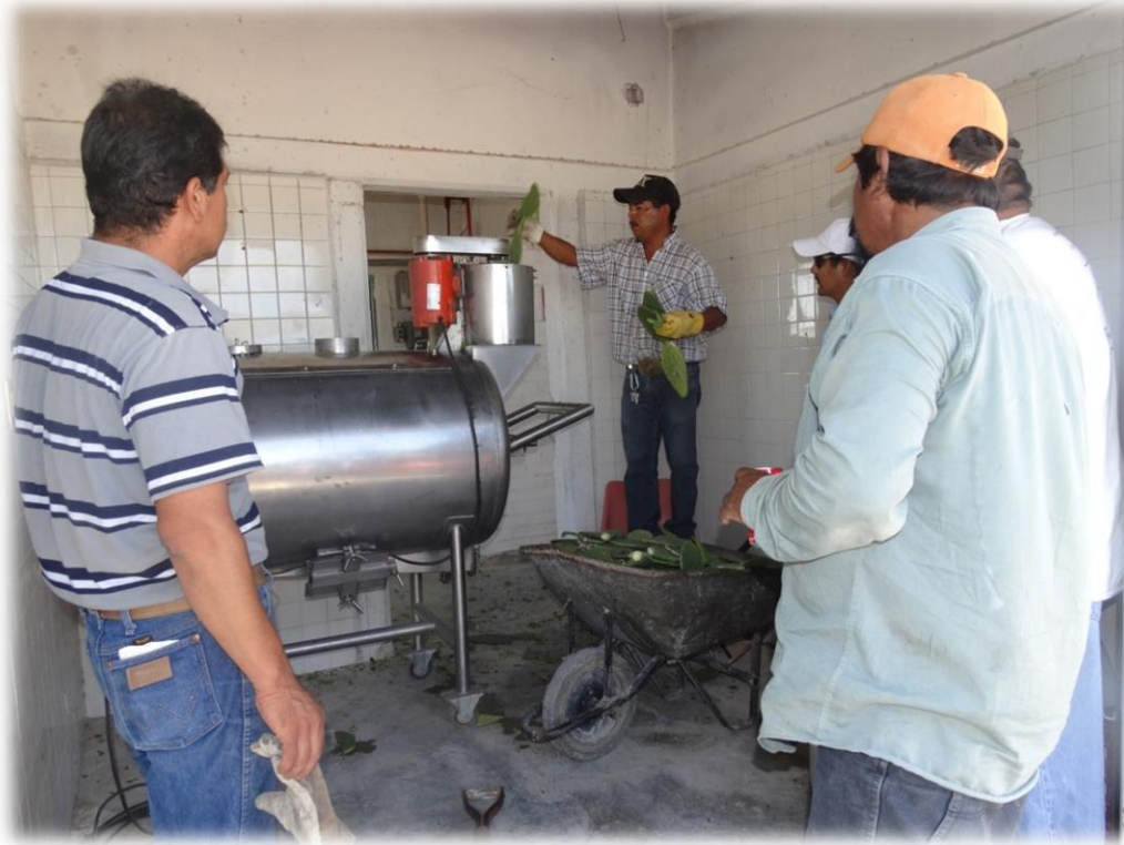
Instalación del Biodigestor en el CBTa 22, preparatoria local. Adiestramiento a los ordeñadores.
