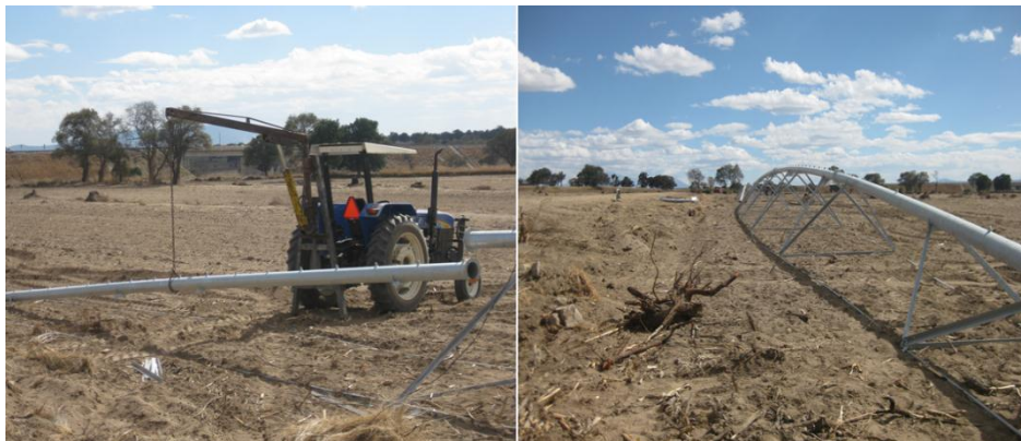
Figura 4.6 Tendido y ensamble del pivote central
