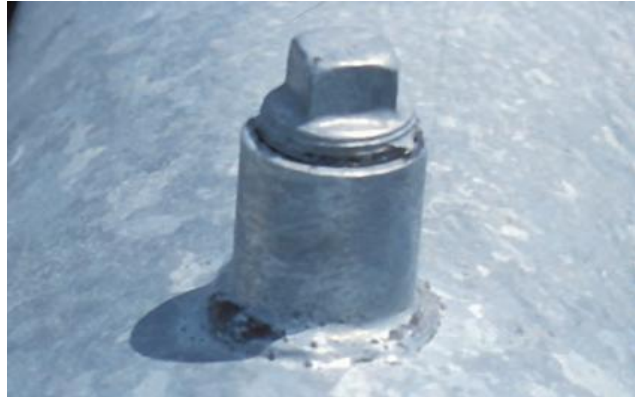
Figura 2.15 Toma de agua a lo largo de la tubería
