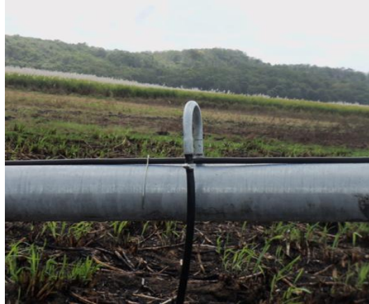
Figura 4.7 Colocación de complementos (U, bajantes, cable)
