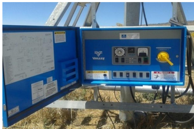
Figura 2.17 Panel de control manual básico de un sistema de riego por pivote central (Valley Irrigation Systems).
