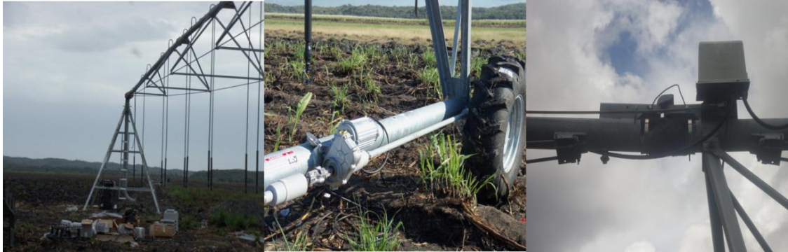
Figura 4.9 Ensamble de torres y colocación de complementos en cada tramo
