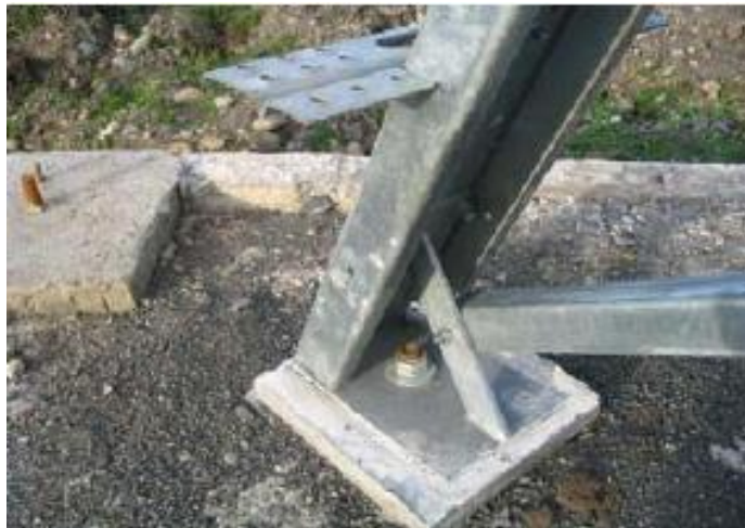
Figura 2.6 Perno de anclaje
