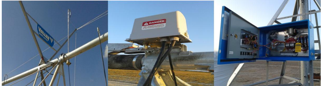
Figura 4.11 Colocación de accesorios de control
