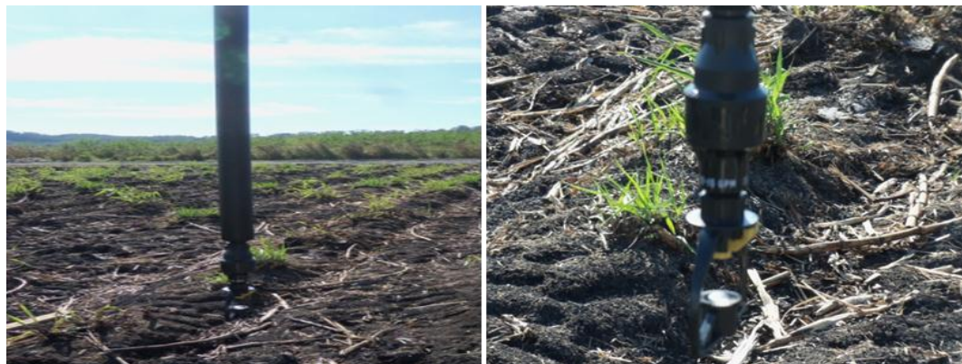
Figura 4.10 Colocación de contrapesos, reguladores de presión y aspersores
