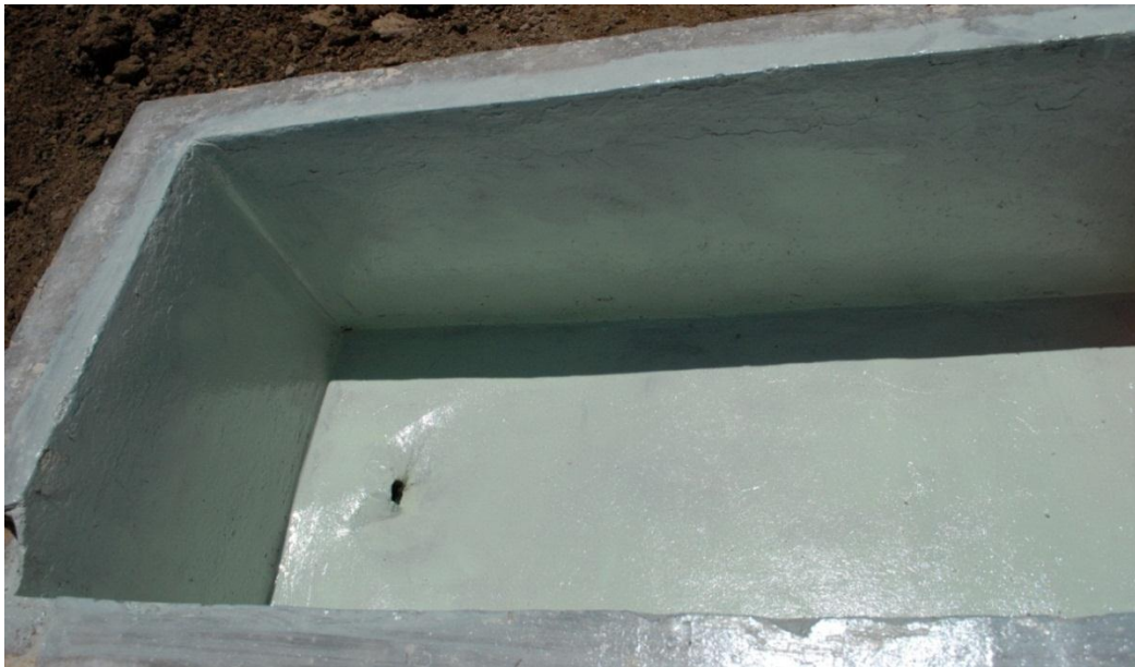
Figura 7. Aplicación del Recubrimiento epòxico impermeable.
