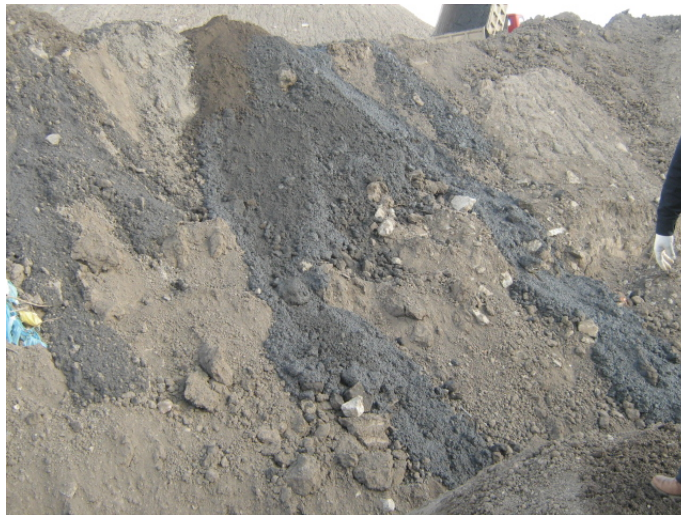
Figura 3. Demostración de una biopila antes de ser el tratamiento por composteo
