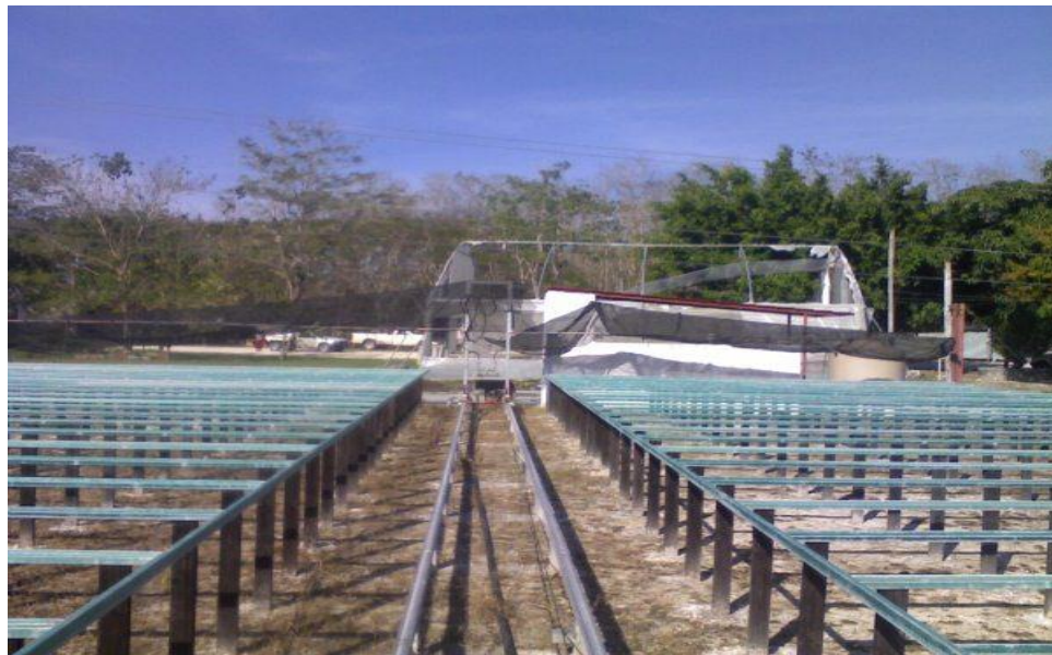
Fig. 7 Estructura para almácigos para malla sombra.
