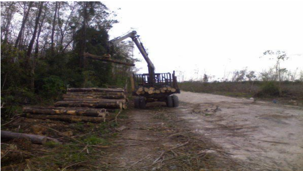
Fig. 19 Extracción a patio de almacenamiento.
