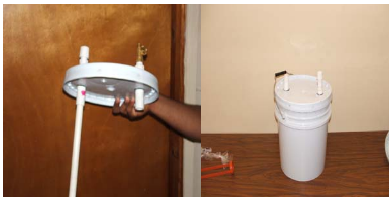
Figura No. 16. Construcción de los biodigestores para retener bacterias anaeróbicas.
