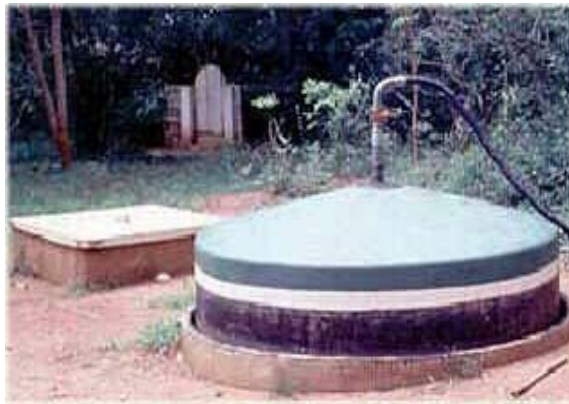
Figura No. 3. Esquema de un biodigestor tipo Hindú.
