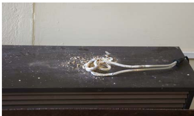
Figura No. 19. Calentador eléctrico roto durante el experimento de la fase II.
