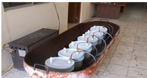
Figura No. 17. Colocación de cada uno de los biodigestores.
