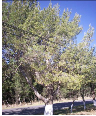
Figura 19. Obstrucción al cableado telefónico.
