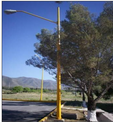
Figura 20. Obstrucción al alumbrado público.
