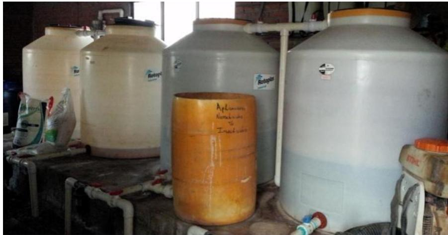
Figura 10. Depósitos de fertilizante en cuarto de fertirriego.
