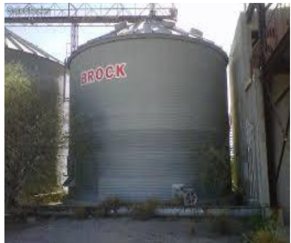
Figura 28. Vista externa de silos
