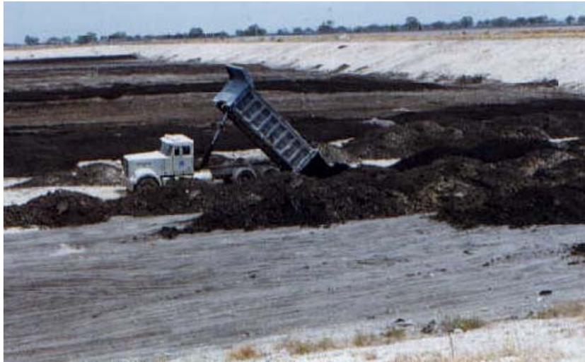
**Figura 2-1.** Confinamiento de lodo deshidratado en un relleno sanitario (Pissani, 1998).
