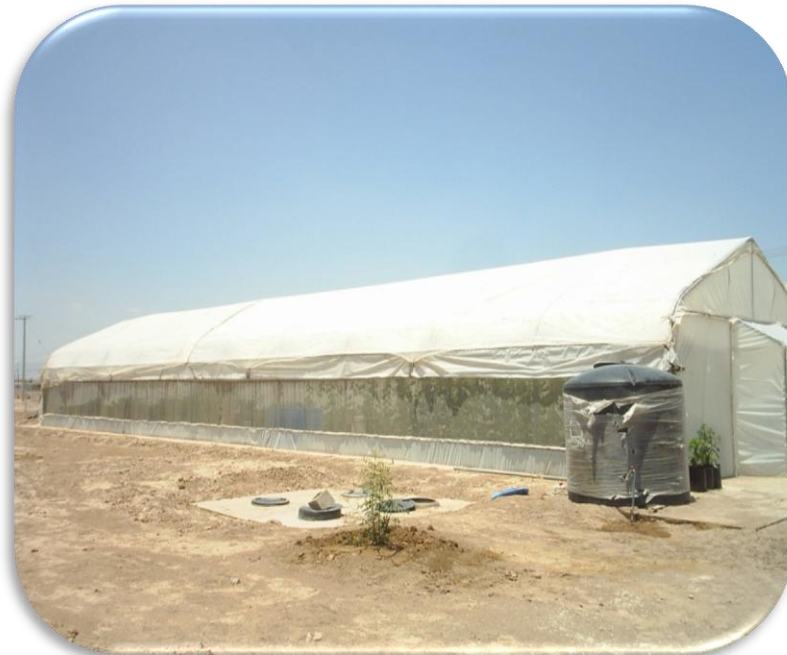
Figura 1. Invernadero tipo unitúnel capilla con ventilación lateral (antiáfidos)
