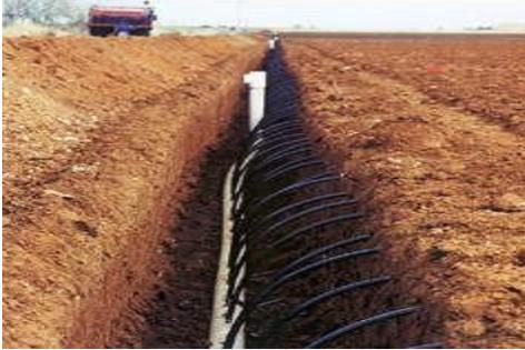
Fig. 19 Riego por goteo subterráneo.
