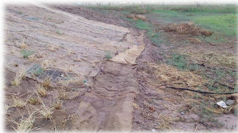
**Figura 3.7. Colocación de costales para captación del suelo**
