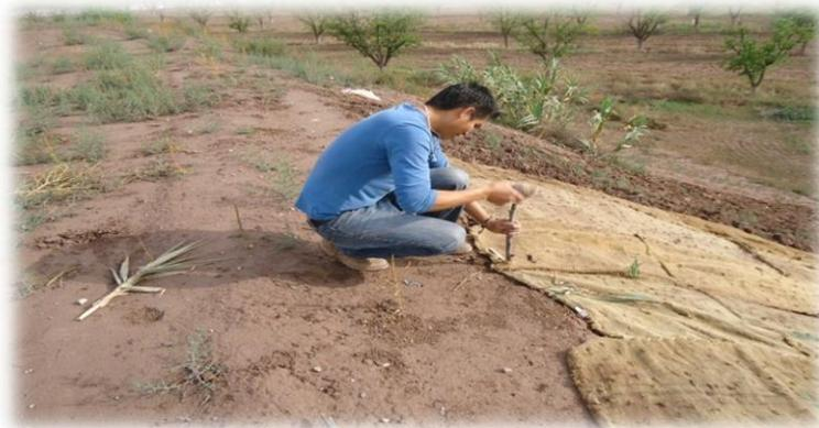
**Figura 3.6. Colocación de estacas**
