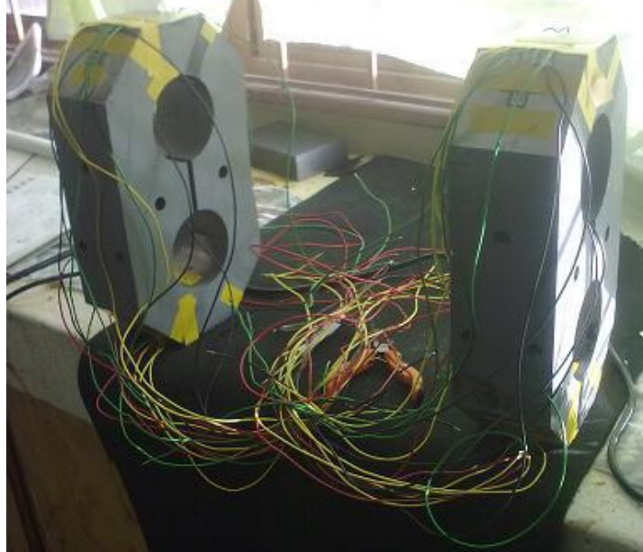
Figura B5. Cableado de sensor octagonal.
