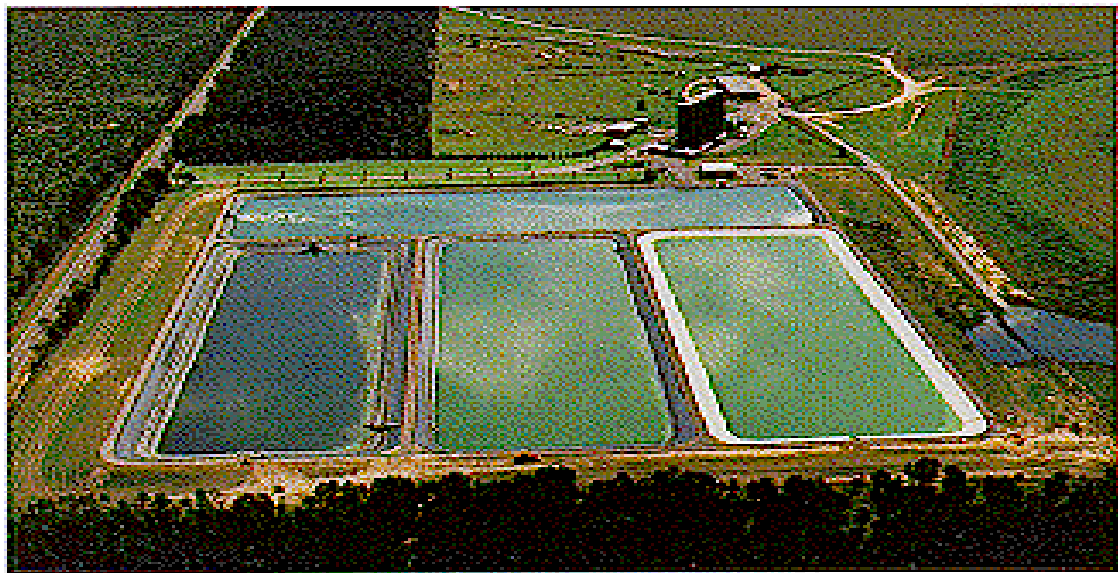
Figura 2.4. Planta de tratamiento para aguas residuales de estanques de estabilización.
