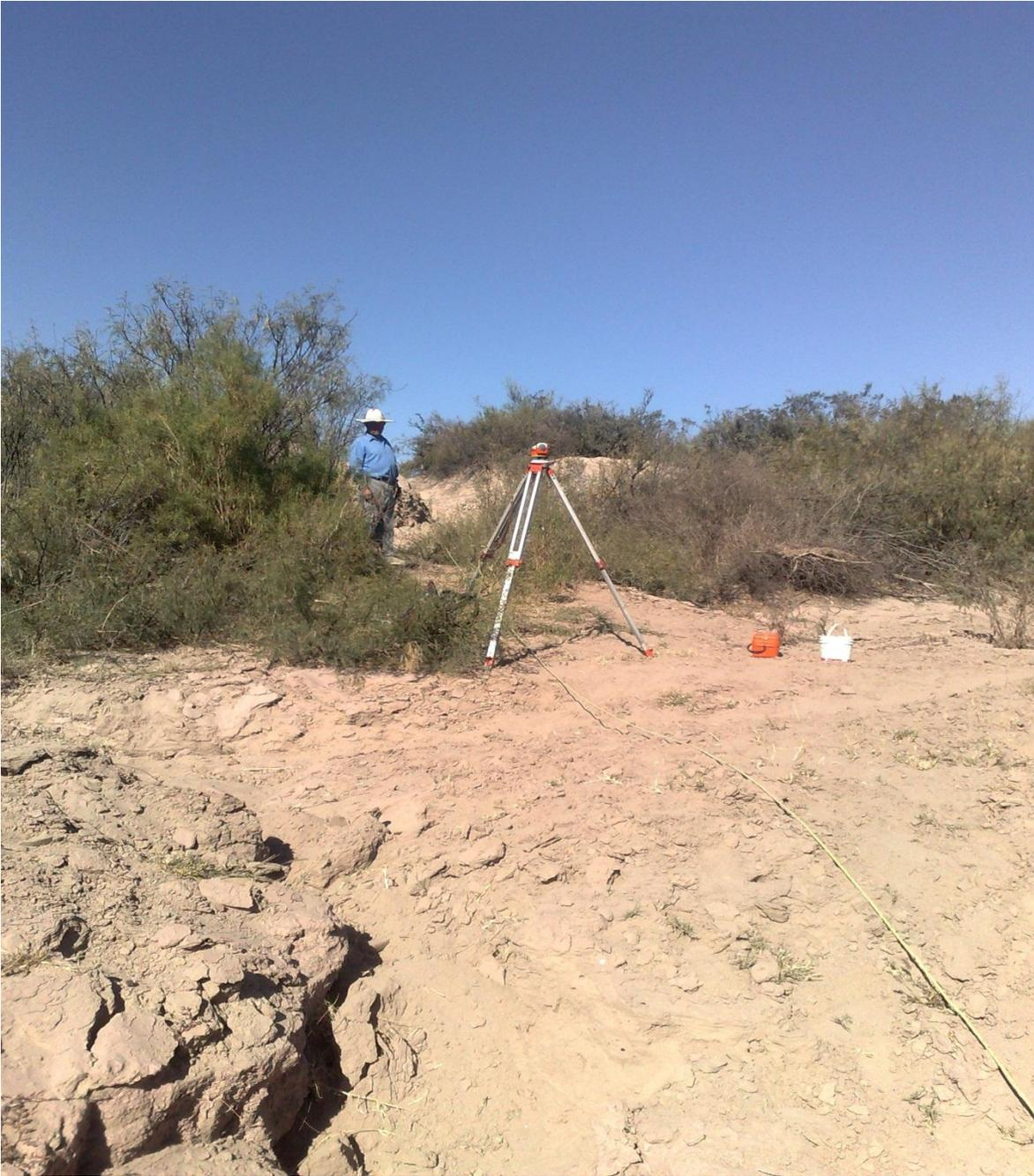
Aprendice. Levantamiento para determinar el vaso de almacenamiento de la presa
