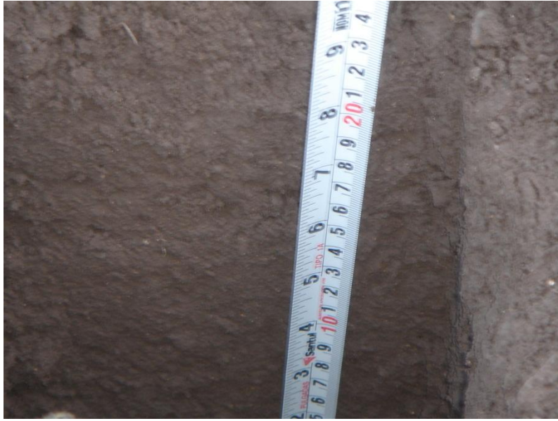
Figura 13. Medición de la profundidad para la instalación del Thermocouple
