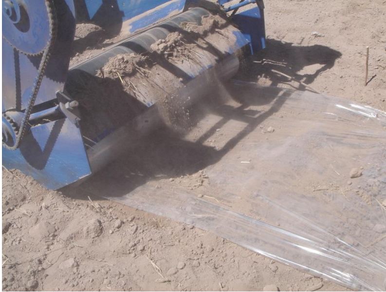
Figura 9. Implemento agrícola para enterrar el plástico subsuperficial a una profundidad de 40 cm bajo la superficie a lo largo de la cama de siembra.
