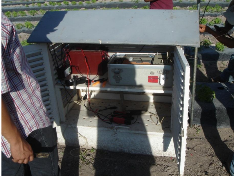
Figura 11. Instalación de los aparatos en una garita.
