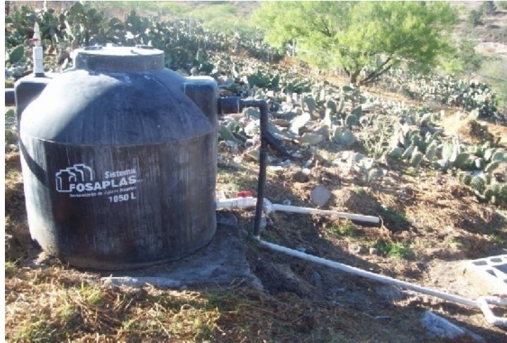
Figura 3.2. Instalación del biodigestor anaerobio
