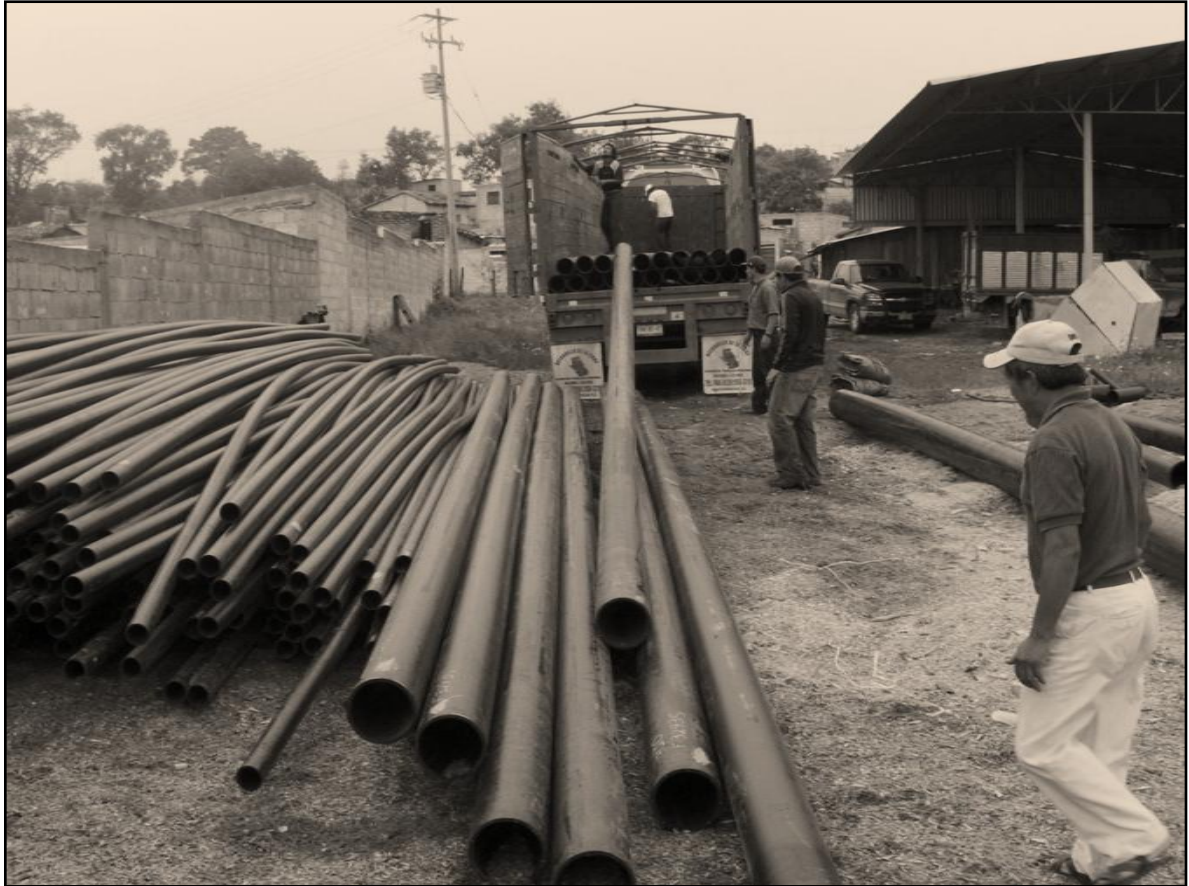
Figura 3.6. Adquisición de la tubería de PEAD (Extrupak)
