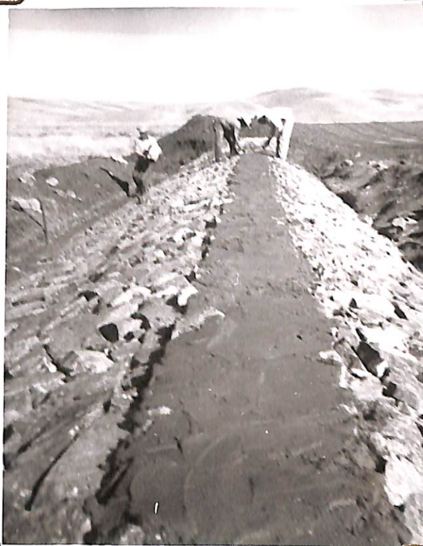
Foto 3. Vista del vertedor colocando la piedra para el zampeado.
