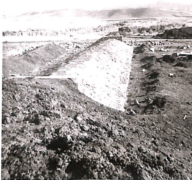
Foto 4. Vista de un vertedor donde se pueden apreciar los muros de cabeza, el cimacio y los taludes de zampeado junteado
