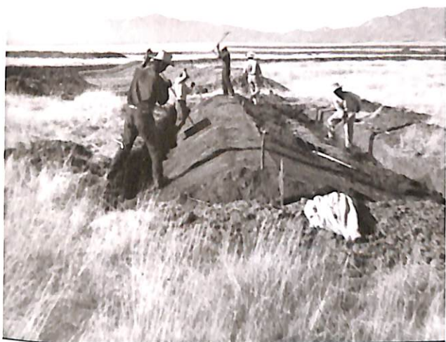
Foto 2. Vista de un vertedor de los bordos Bajío Los Patos. Véase el relleno - apisonado.
