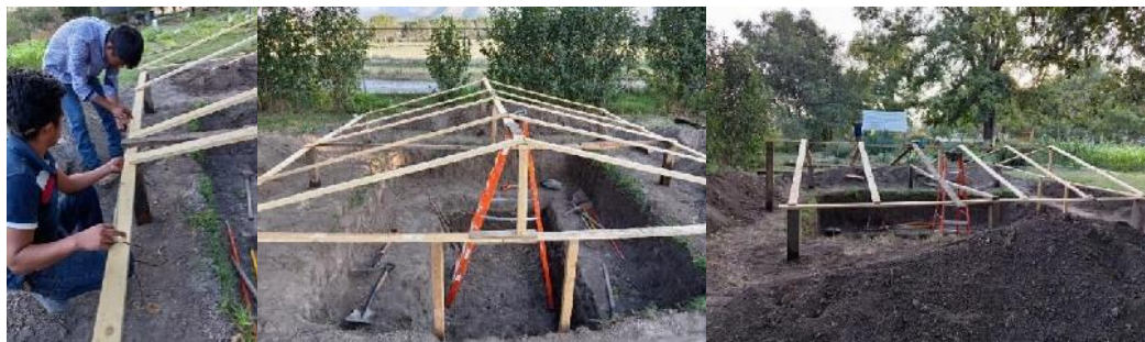
Figura 8 Colocación de duelas
