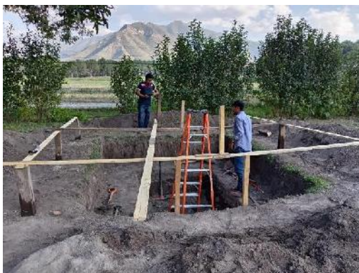
Figura 7 Colocación de vigas
