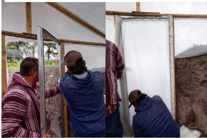
Figura 11 Puerta de acceso
