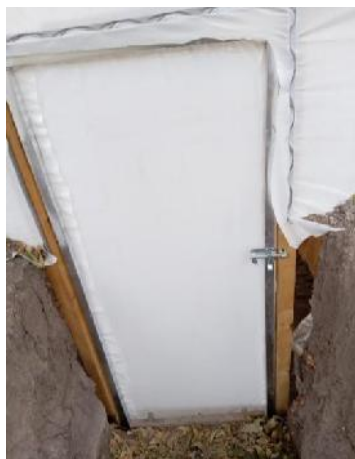
Figura 12 Colocación de pasador metálico
