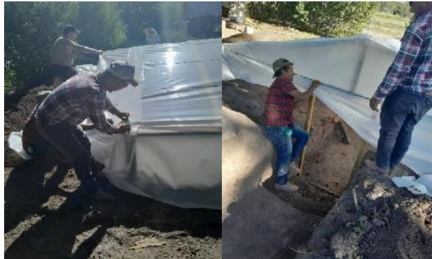
Figura 10 Colocación de la cubierta
