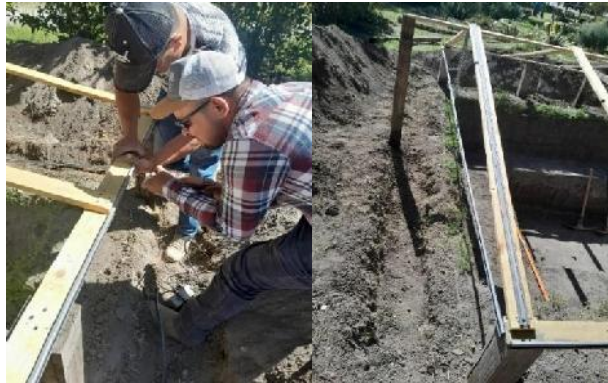
Figura 9 Colocación de perfil sujetador
