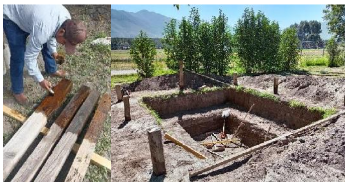
Figura 6 Instalación de soporte
