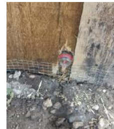
Imagen 36: Ubicación del desagüe al exterior.
