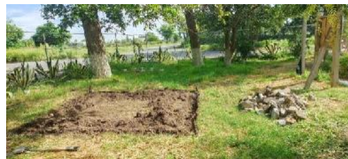
Imagen 15: Señalado, escavado y rellenado de zanja con piedras
