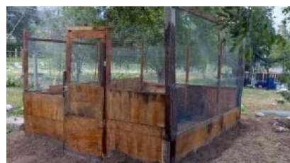
Imagen 26: Vista final tras la instalación de la malla y aplicación de aceite.
