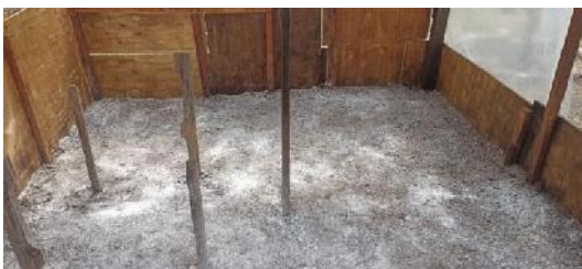
Imagen 38: Aplicación de cal.
