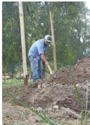
Imagen 17: Instalación de postes.
