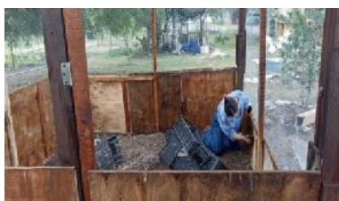
Imagen 24: Aplicación de aceite en triplay.
