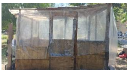
Imagen 32: Colocación de hule como cortina.
