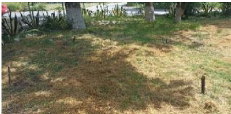
Imagen 14: Ubicación, medición y trazado del terreno.
