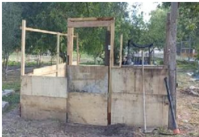
Imagen 23: Instalación de puerta, paredes.
