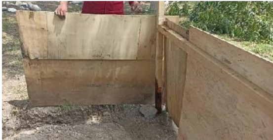
Imagen 21: Vista previa a la instalación del triplay y medición exacta.
