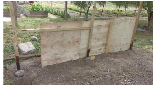
Imagen 19: Instalación de postes horizontales para mayor rigidez.
