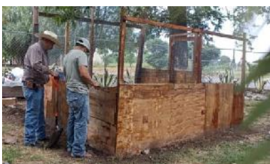
Imagen 25: Instalación de malla.
