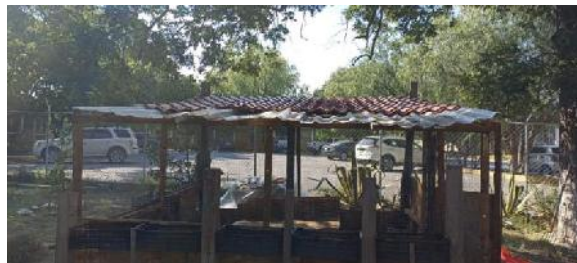
Imagen 29: Vista final de la instalación del techo.
