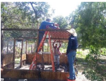
Imagen 30: Instalación de láminas para techo del gallinero.
