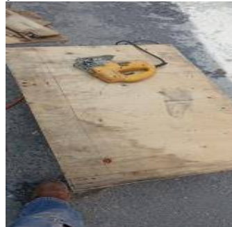
Imagen 20: Corte exacto a la medida deseada para instalación.
