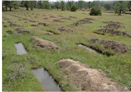
Figura 27. Zanjas Trichera (CONAFOR 2023).
