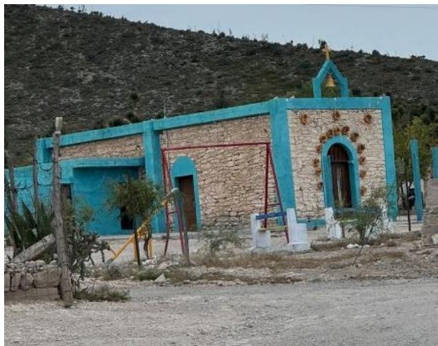
Figura 24 Iglesia Católica Fuente: Imagen Propia
