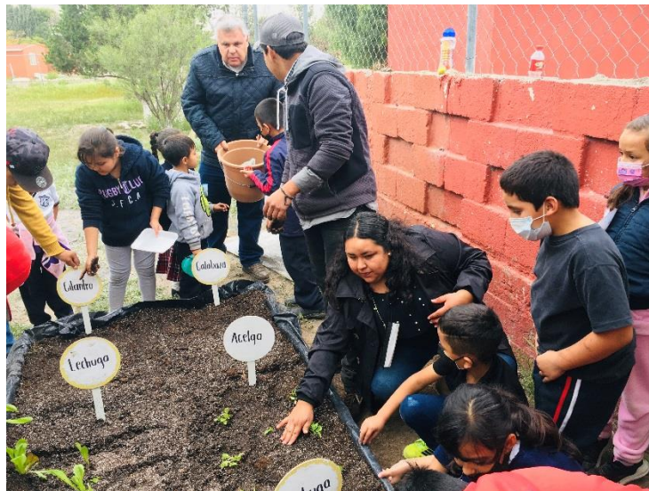
Instalación del huerto escolar
