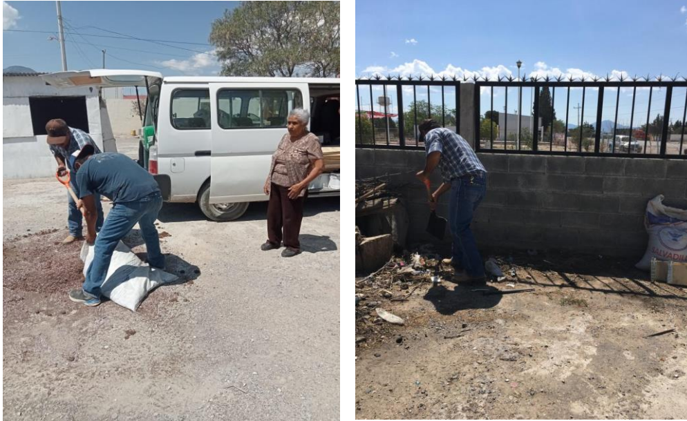
Figura 12 Preparación del sustrato y limpieza del área
