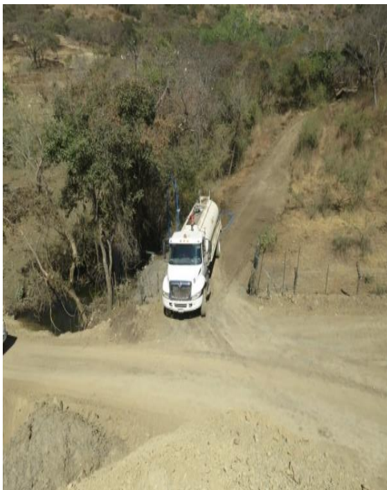
Pipas de agua preparada para realizar riegos sobre los caminos para evitar la dispersión de polvo.
