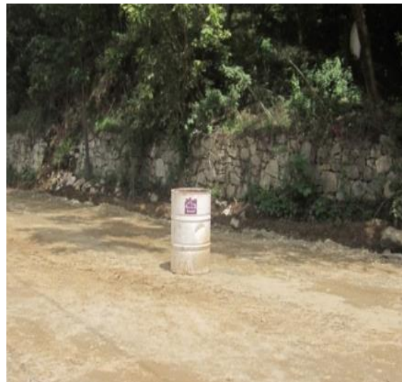
16.- Colocación de contenedores en áreas de trabajos para el depósito de basura.
