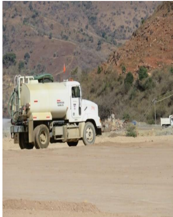
Pipas de agua preparadas para realizar riegos sobre los caminos para evitar la dispersión de polvo.
