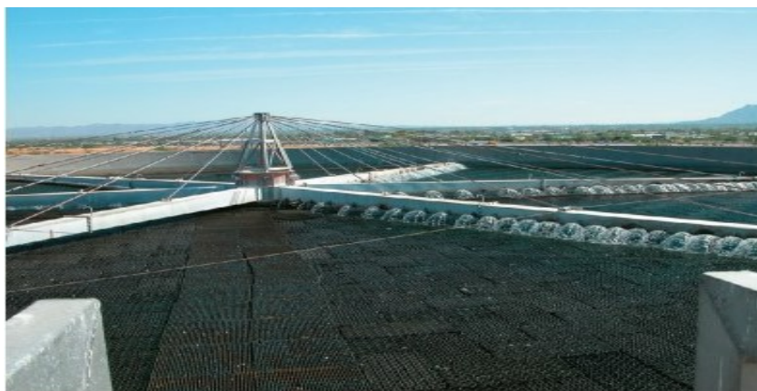
Figura 1. Un biofiltro percolador o biotorre. Este se compone de muchas unidades de plástico apiladas unas sobre otras. Las dimensiones del biofiltro pueden ser 20 m de diámetro por 10 a 30 m de profundidad (Gerba & Pepper, 2019).
