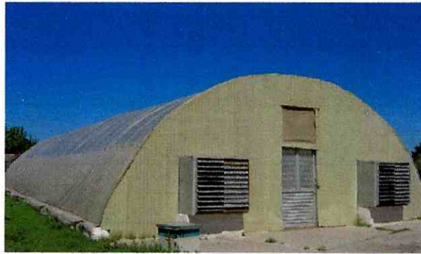
Figura 3.1. Invernadero de la Universidad Autónoma Agraria Antonio Narro-Unidad Laguna, lugar donde se desarrollo el presente trabajo. UAAAN-UL, 2004.
