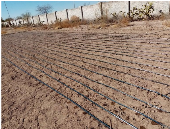
FIGURA 2.- Instalación de sistema de riego.
