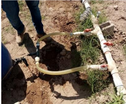
FIGURA 5.- Instalación del Venturi y aplicación.
