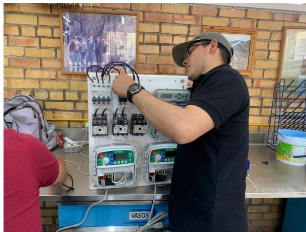
Figura 13 Instalación de componentes en tablero
