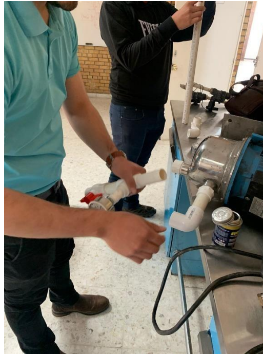
Figura 8 Armado del sistema de control de caudal parte 1
