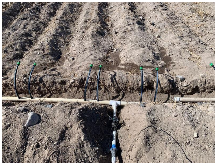
Figura 23 Lavado de línea distribuidora
