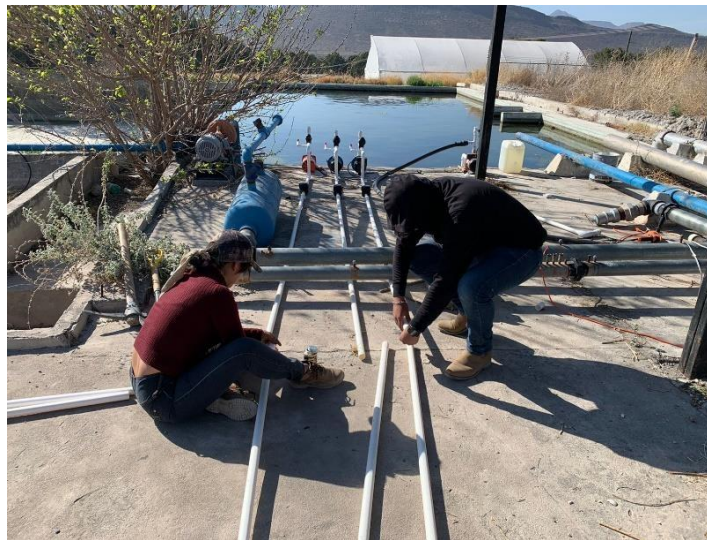
Figura 20 Instalación de línea principal parte 1
