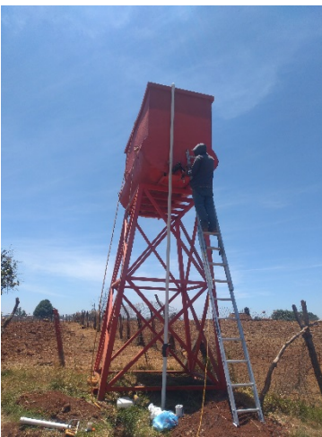
Figura 35.- Conexión de sistema de riego con cisterna metálica 5,000 lts.
