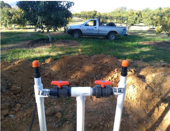
Figura 8.- Cruceo doble líneas secundarias, válvulas cepex 2" doble tuerca, piezas cedula 40, válvulas de aire WR 1", manómetros y tubería pvc.
