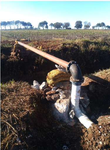
Figura 27.- Cruce de río con tubería de 6" de fierro, codos bridados de fierro, empaques neopreno 6", bridas 6" cedula 80 y tubería de pvc 6" rd-41.
