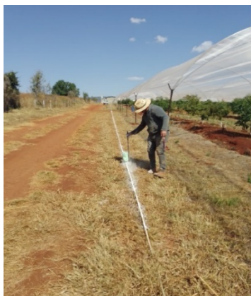
Figura 45.- Trazo con cal para excavación a lado de aguacatera instalada en 2019.
