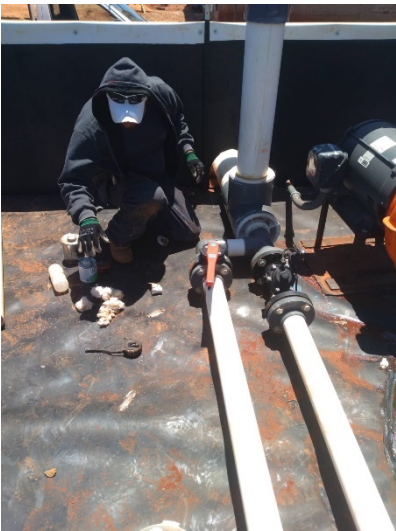
Figura 42.- Instalación de válvula hidráulica de alivio de presión 3" Bermad con brida y válvula de desfogue de 3" con válvula mariposa cepex con bridas y tornillos, en te de 8" cedula 80".
