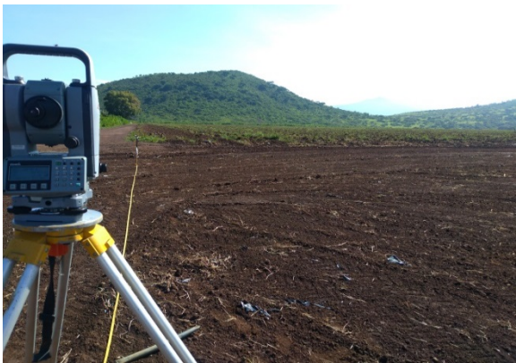
Figura 4.- Medición de terreno mediante Estación Total Gowin y cinta métrica de 50 más.
