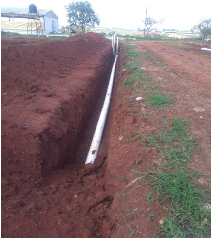
Figura 39.- Tapado de Zanja, Tubería de 200 mm Clase-5.
