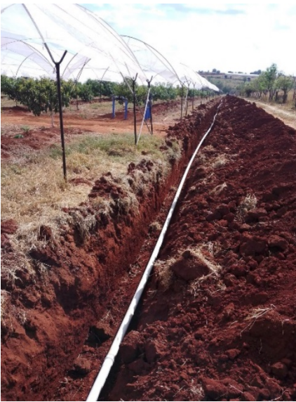
Figura 51.- Tubería de 3" rd-41 instalada en zanja lista para tapar.
