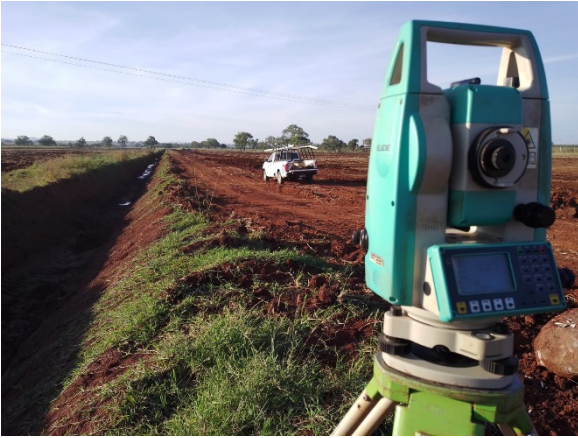
Figura 40.- Trazo en Campo mediante Estación Total Gowin.
