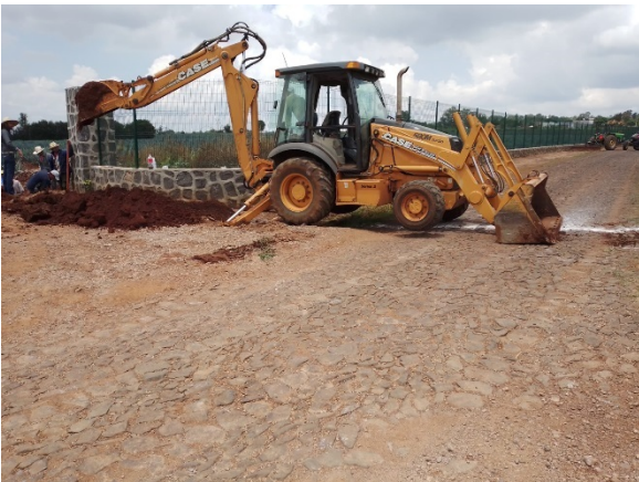
Figura 43.- Cruce de camino con retro excavadora.
