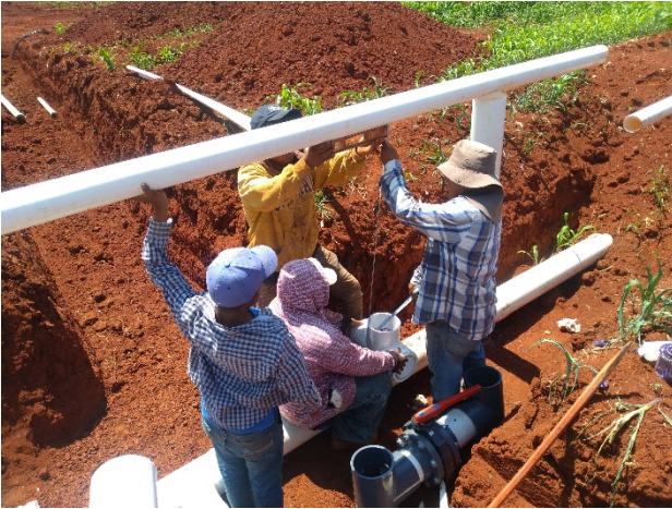
Figura 19.- Medición para la colocación de válvula de control de 6" de línea principal.
