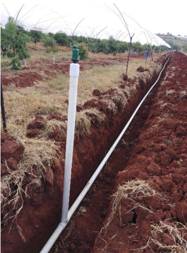
Figura 52.- Válvula de aire irritec de 1" instalada sobre tubería de conducción de 3" rd-41.
