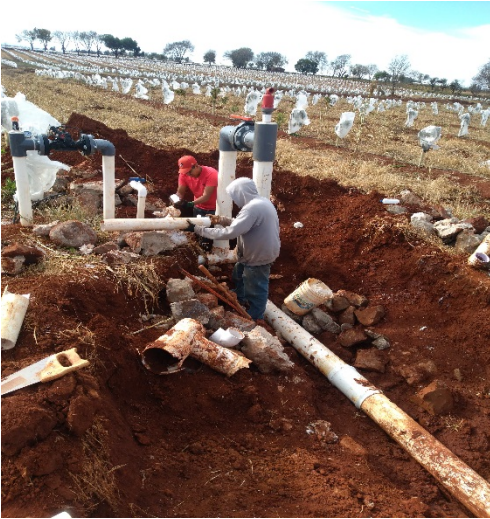
Figura 30.- Reparación de válvula de línea secundaria de 3" con válvula hidráulica reguladora de presión, y línea principal de 160 mm c-5 quebradas por piedra al realizar sus atraques.
