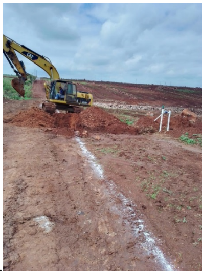
Figura 58.- Trazo con cal para excavación, para colocar línea principal de 200mm c-5
