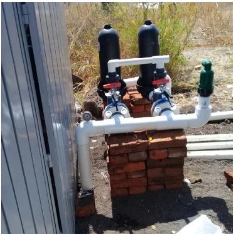
Figura 1.- filtración fija con retro lavado, 2 filtros anillos, válvulas mariposa 3" wade rain, válvulas cepex 2" doble tuerca, conexiones pvc, y válvula de aire.
